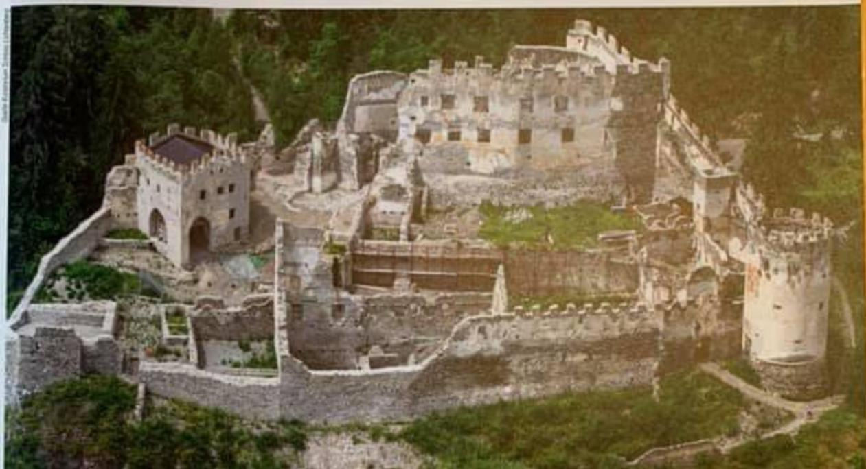
Schloss Lichtenberg im Jahre 2008. Die Sicherung der Stützmauer des Schlossgartens (Bildmitte) ist im Gange. Die Umfassungsmauer und die Reste des Hildbrandsturms (im Vordergrund) sind gesichert und die Südwand des großen Palas stabilisiert (im Bild oben).
